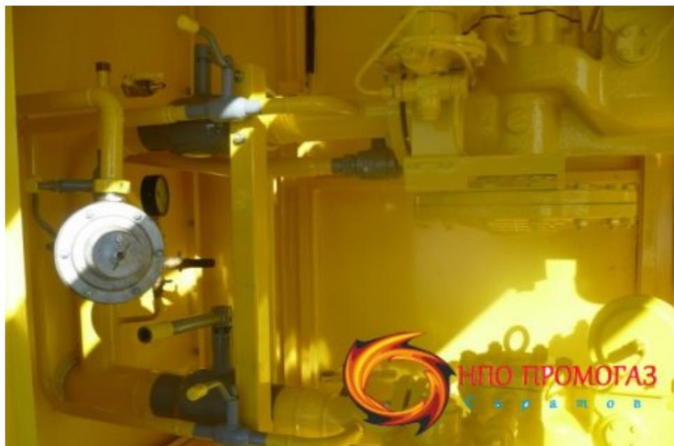
Модульный распределительный пункт МРП-7000 это комплекс оборудования, применяемый в газовых сетях. Внутренний состав МРП-7000 включает в себя газовые редукторы в количестве двух штук, предохранительную и запорную арматуру. Корпус, представляющий собой металлический ящик с дверями с двух сторон, окрашен специальным покрытием, препятствующим коррозионному воздействию на его материал.
